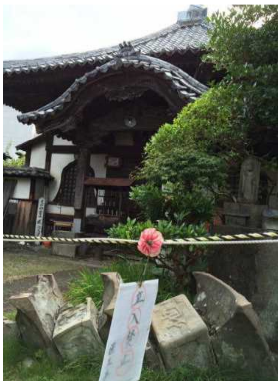
本堂前。現在は規制線は外されている
